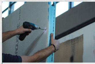
Připevnění desek k nosným profilům
